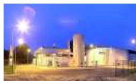
Biogazownia Liszkowo źródło www.nettp.pl
